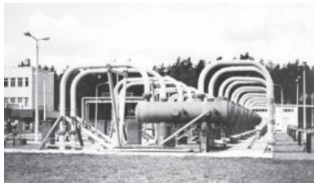
Leistungen der Außenmontage des ZRAW in der Zentralstation Steinitz im Erdgasfeld Salzwedel/Peckensen Zeitzeugen-Archiv
