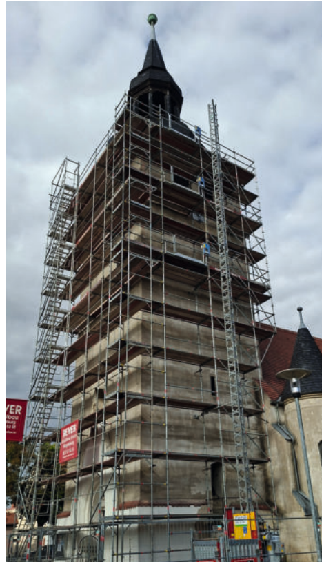
Gommern - beginnende Bauarbeiten am Turm
